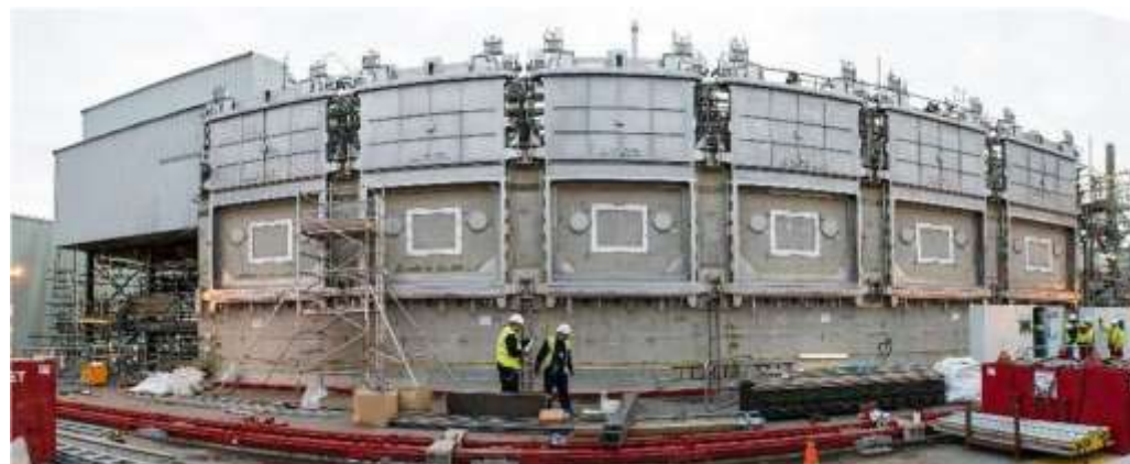
サイロドアの設置 取出し用アクセス貫通孔
