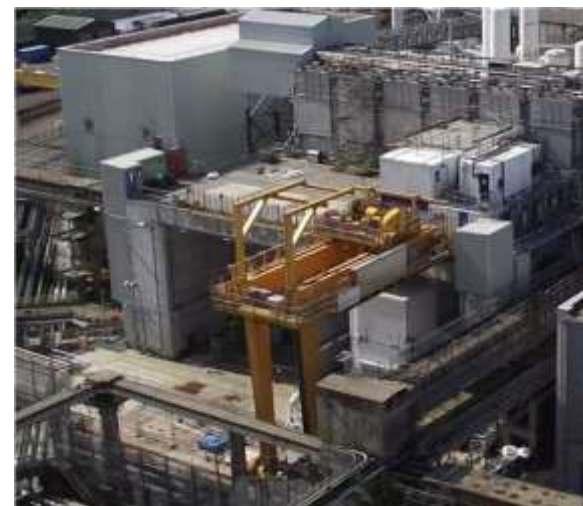
取出し装置の据付
