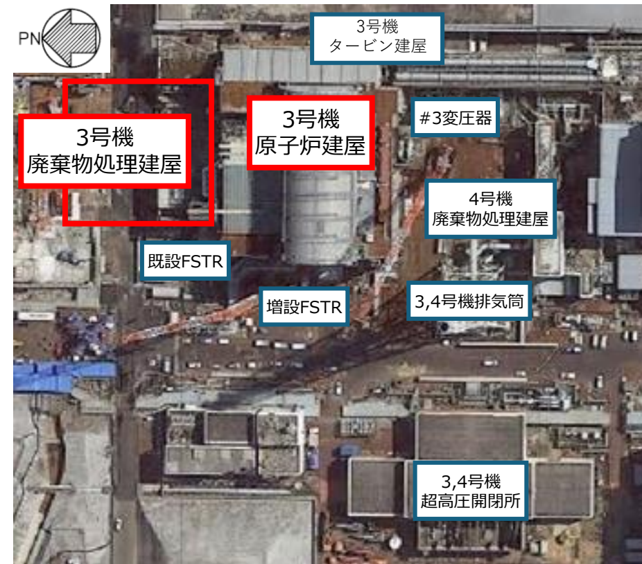
3号機 原子炉建屋 周辺の施設
