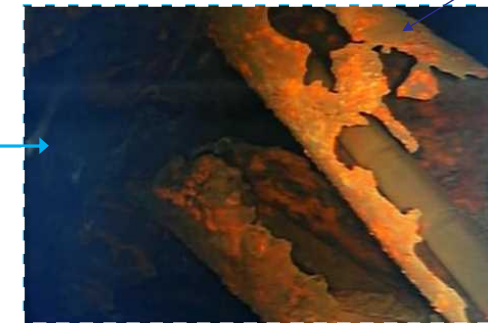
円筒状の構造物 (CRガイドチューブと推定)
