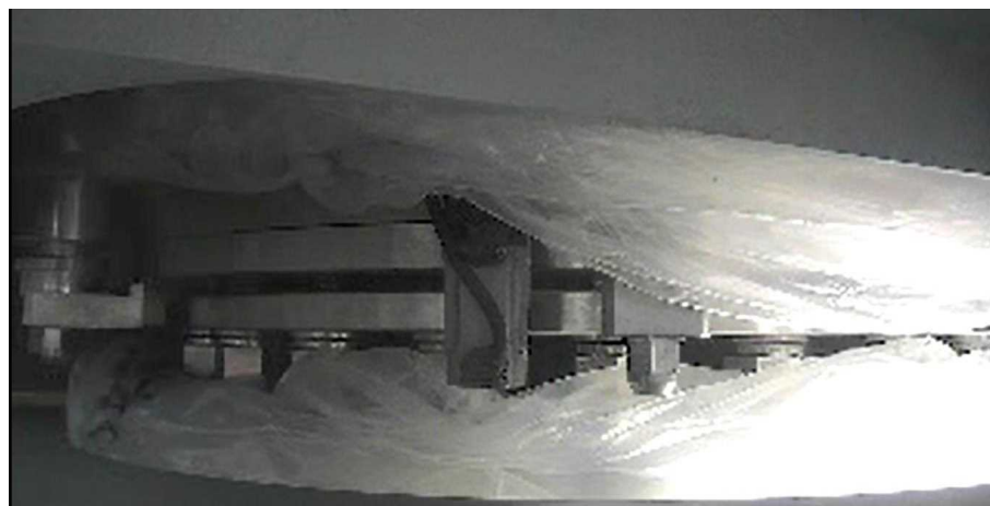
テレスコ式装置とX-6ペネ接続構造/接続管の接続作業完了 (接続部分を上から見た様子)
