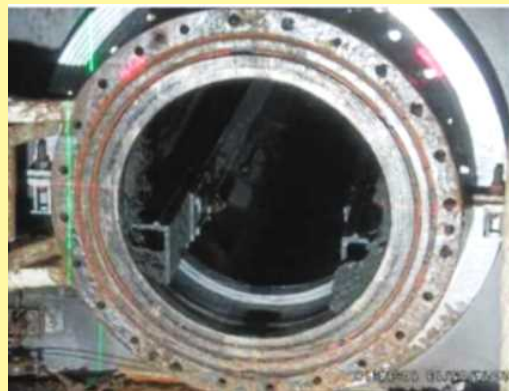
堆積物の除去 完了
