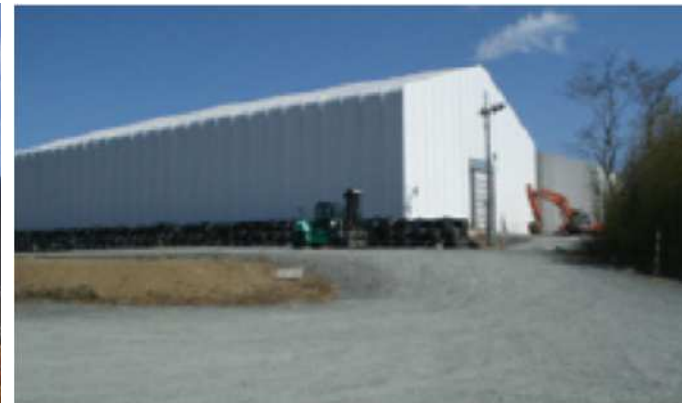
ガレキ貯蔵施設
