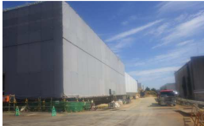
新廃棄物貯蔵施設
