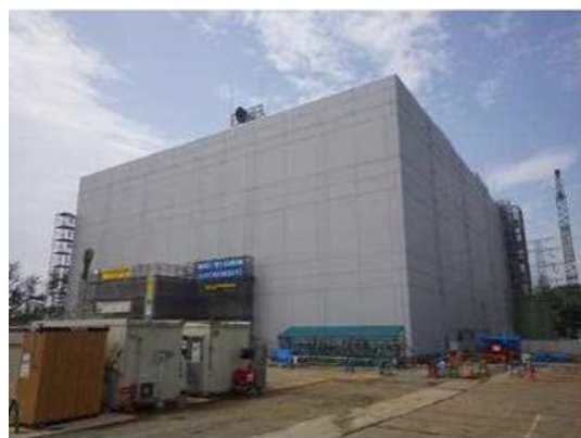
雑固体廃棄物焼却設備
