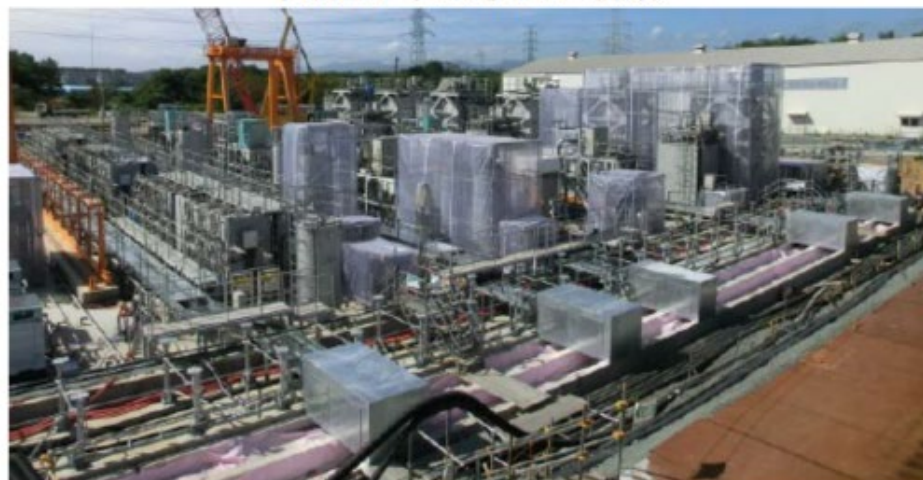
多核種除去設備 機器の設置状況 平成24年9月16日撮影
