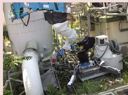
クローラ・クレーンロボット コラボレーション
