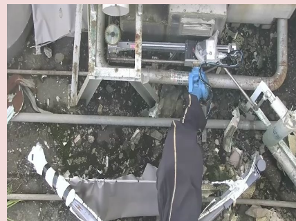
ピットカバー切断
