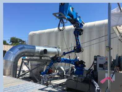
クローラ・クレーンロボット コラボ操作訓練
