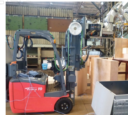
屋上保護層除却ロボット開発及び工事
