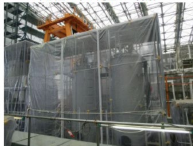
吸着塔 (処理カラム) 平成25年3月27日撮影
