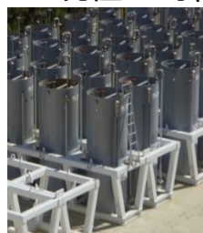
第二セシウム 吸着装置 (SARRY) 吸着塔
