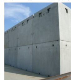
セシウム吸着装置 (KURION) 吸着塔
