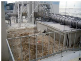
津波襲来 電源喪失
